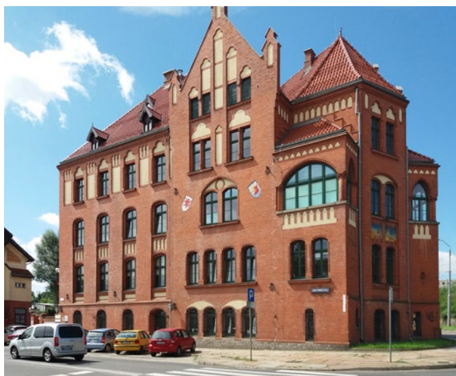
Fot. 1. Siedziba Oddziału Zakładu Gazowniczego przy Tamie Pomorzańskiej w Szczecinie
