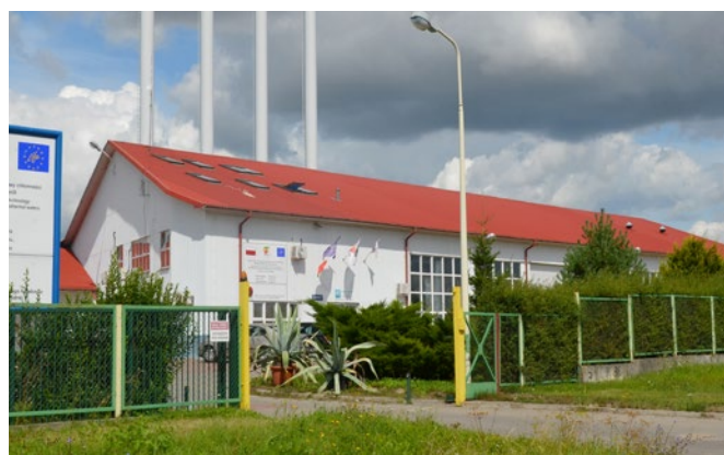
Rys. 4. Ciepłownia geotermalna w Pyrzycach
