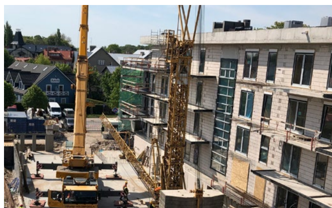
Fot. 1. Budowa dwóch budynków mieszkalnych wielorodzinnych oraz garaży wraz z niezbędną infrastrukturą techniczną. Dziwnów, ul. Kaprała Koniecznego 7A – stan surowy zamknięty
