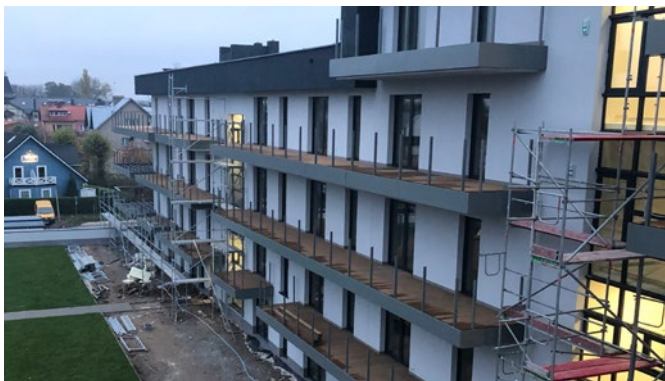
Fot. 2. Budowa dwóch budynków mieszkalnych wielorodzinnych oraz garażu wraz z niezbędną infrastrukturą techniczną. Dziwnów, ul. Kaprała Koniecznego 7A – „stan deweloperski”
