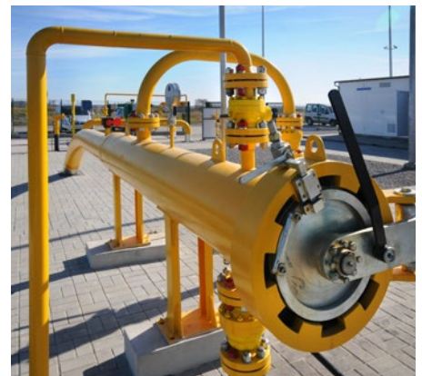
Fot. 6. Śluza nadawczo-odbiorcza tłoka inteligentnego
