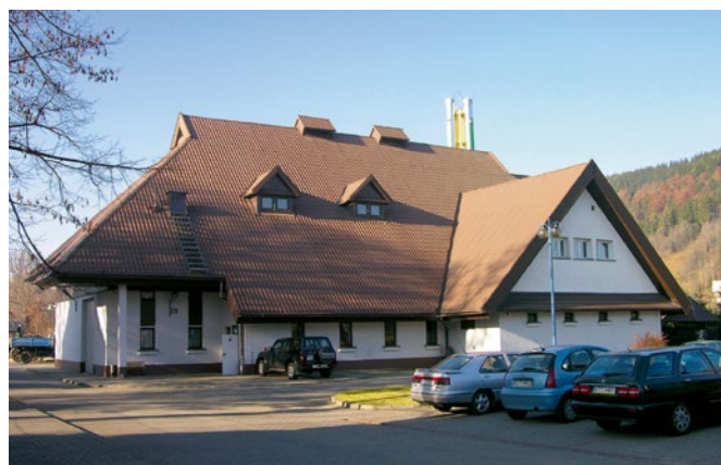
Rys. 10. Kotłownia szczytowa (centralna) w Zakopanem
