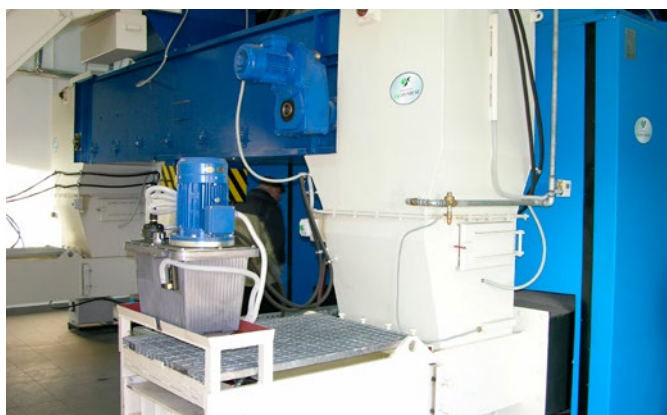
Rys. 13. Kocioł szczytowy opalany biomasą – układ doprowadzenia paliwa
